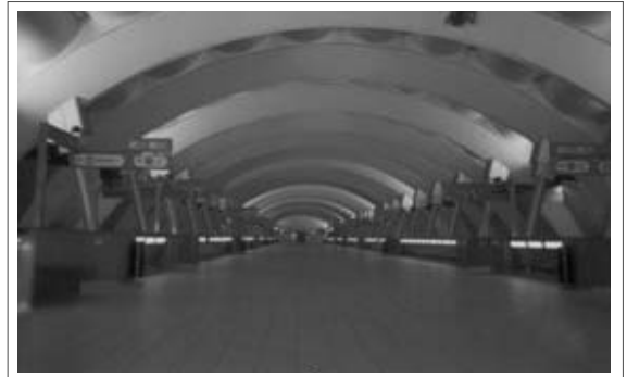
[그림 12] 시공완료 후 전경(베네치아)
