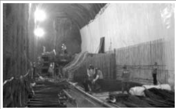
[그림 11] 측벽부 철근 조립
